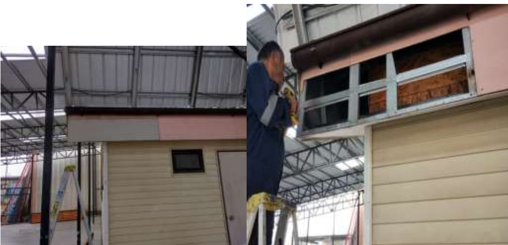
Reemplazo plancha en patio Patagona (rota en recreo)
